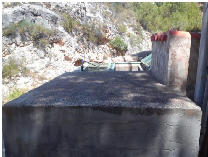
Imagen. Pozo El Llosar.
