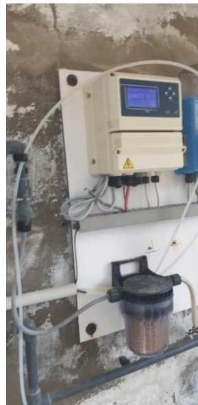
Imagen depósito Solana y clorador
