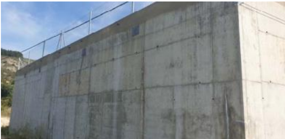
Vista de Depósito Decantador
