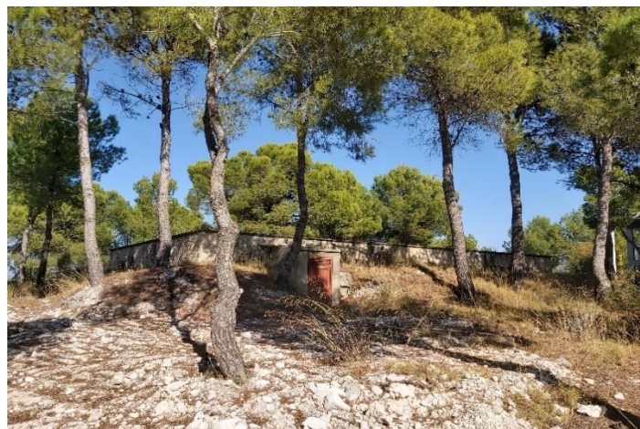
Imagen. Depósito Pinares de Meclí.
